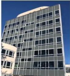
AMSOM habitat rénove son siège pour atteindre le niveau BBC rénovation grâce à une isolation thermique performante, le changement des menuiseries et la réfection de sa façade en mur-rideau.
