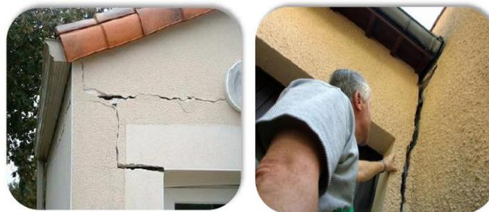
Figure 29 : exemple de dégâts causés par le retrait gonflement des argiles sur l'habitat (Source groupe SMA - photo de gauche - et MEDD - photo de droite)
