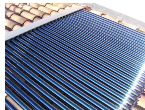
Figure 38 : Capteur tubulaire
