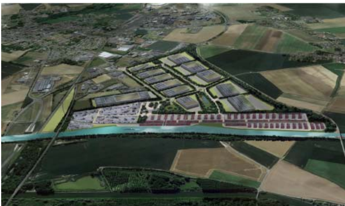
Figure 9 : Visualisation du Port Intérieur de Nesle - Source Syndicat Mixte des Ports Intérieurs du Canal Seine-Nord Europe
