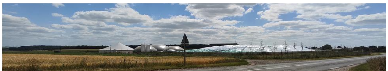
Unité de méthanisation de Cottenchy, juin 2022, Terralto
