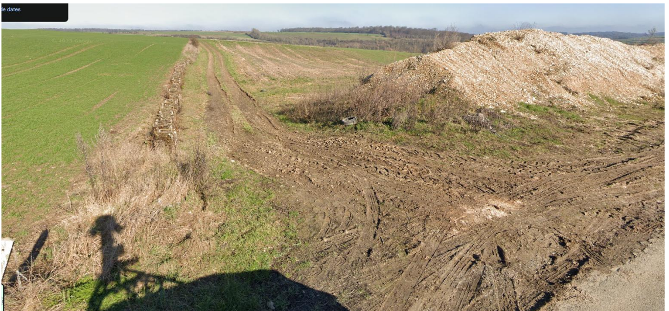
Fascine 11327 (chemin de la grimpette) début 2023 (+/- date de la livraison des ouvrages) ci-dessus (source Google street view), et en décembre 2024 page suivante (photos personnelles).
